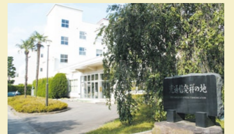
電気通信研究所
